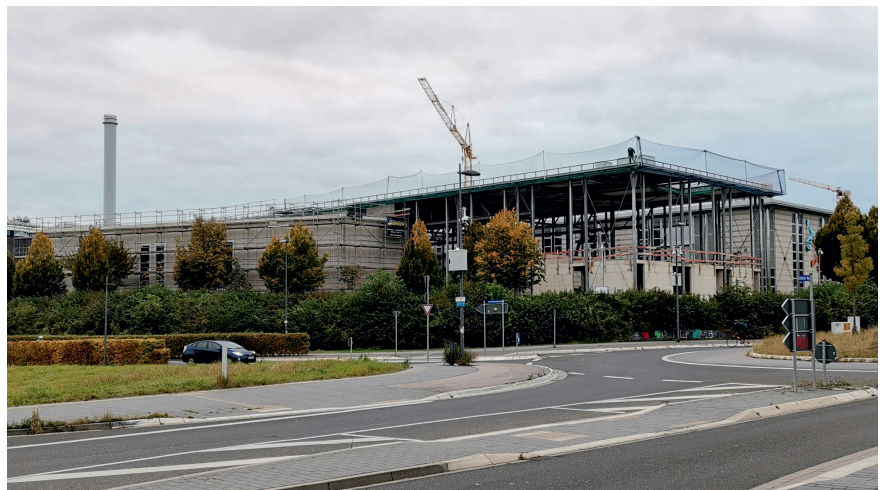
Der Bau des PIC 4.0 schreitet voran und wirft seinen Schatten auf den Campus Melaten © IKV
